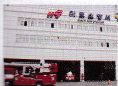
소방서 fire station
