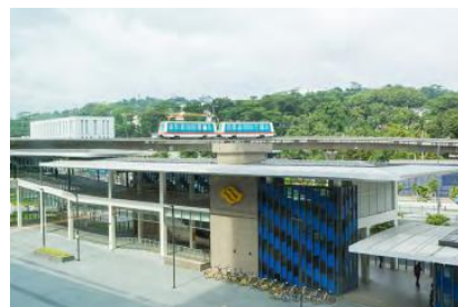
รูปที่ 3 และ 4 Bukit Panjang Integrated Hub ที่เชื่อมต่อรถไฟฟ้ารางเบา รถไฟฟ้าใต้ดิน และรถเมล์
